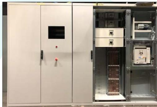
*Tableau TGBT et contrôle commande pour groupe de froid industriel*
