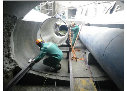
Démontage ancienne conduite dans le passage sous Dranse
