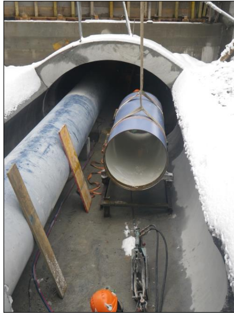
Nouvelle conduite passage sous Dranse
