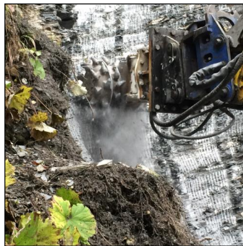
Installation du Blondin
