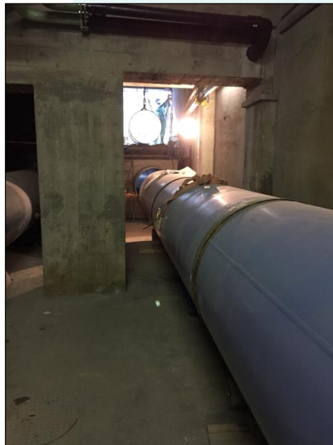
Collecteur : nouvelle conduite
