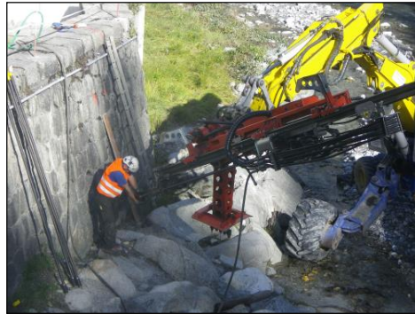
Travaux de forage installation du Blondin
