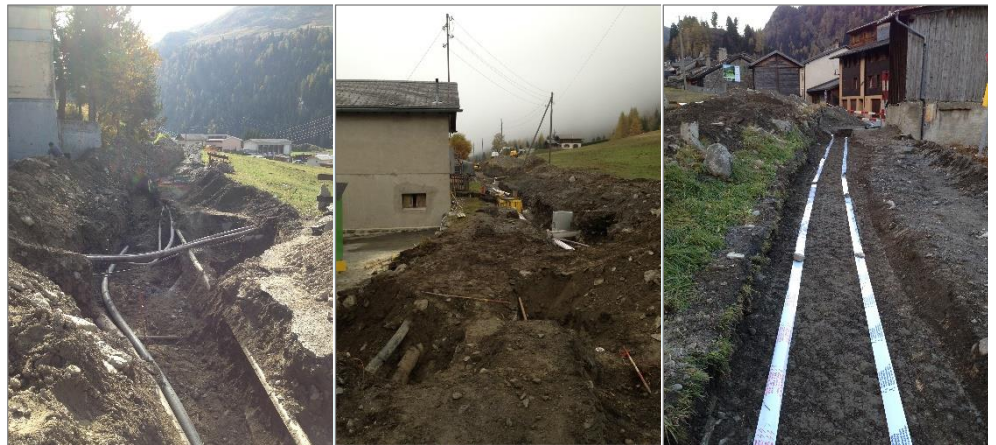
Travaux de génie-civil du secteur Route vieille
