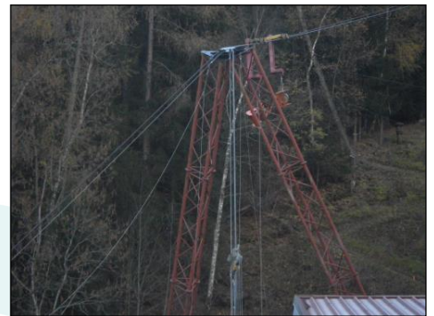
Installation du Blondin
