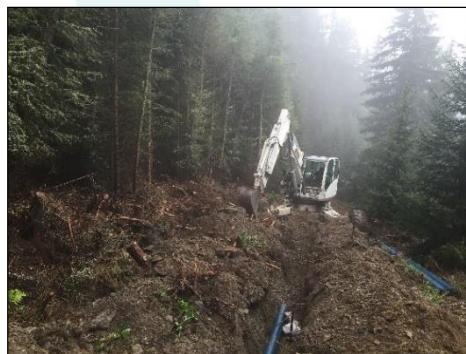
Pose de la conduite pour STEBSP
