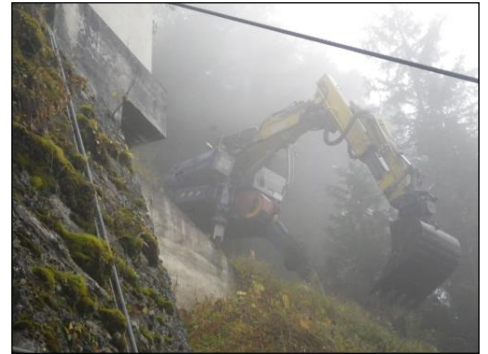
Travaux de forage installation du Blondin
