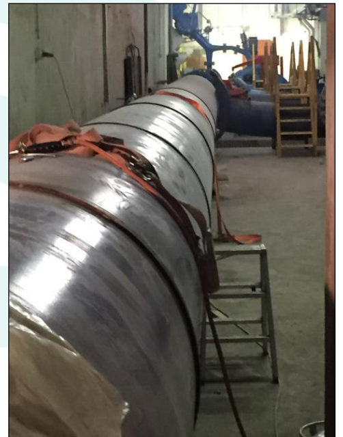
Collecteur : nouvelle conduite
