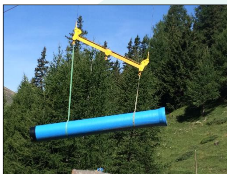
Transport conduite forcée
