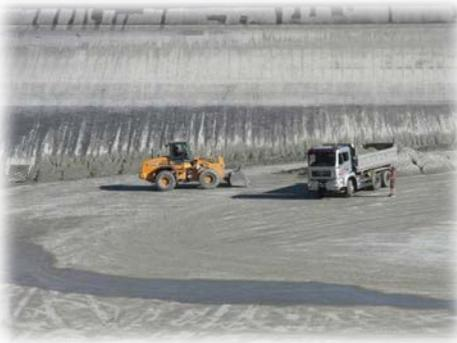
La réfection de l'étanchéité du mur de séparation usine-bassin ont été réalisés durant l'arrêt des révisions de l'usine. En complément à ce projet, une évacuation de l'ordre de 300 m<sup>3</sup> de matériaux déposés ont été évacués vers une décharge locale.
