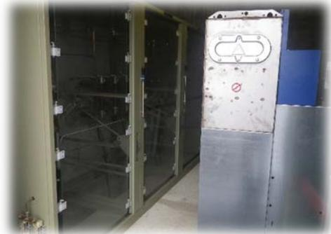
**La réhabilitation de la station transformatrice du Gd-Hôtel à la Fouly** : l'échange des cellules MT 20kV ont permis une sécurité d'exploitation selon les normes en vigueur et une qualité d'alimentation plus sûre, notamment avec le bouclage de la station de la Fouly.
