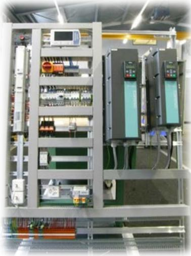
**Migros Brigue** : construction de deux châssis et d'un tableau de ventilation pour la Migros de Brigue.
