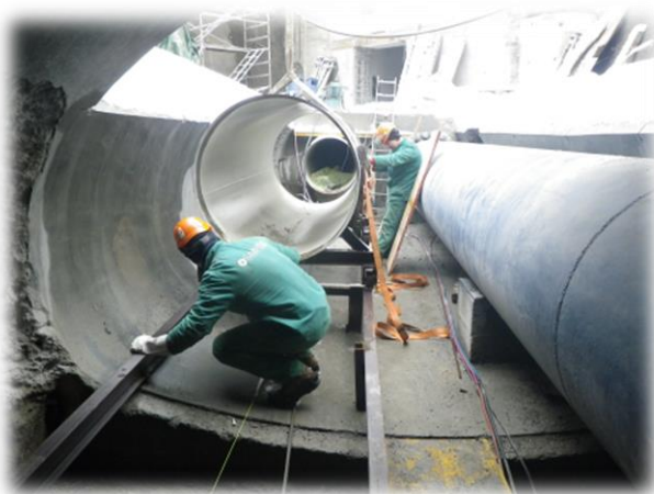
Démontage ancienne conduite dans le passage sous Dranse
