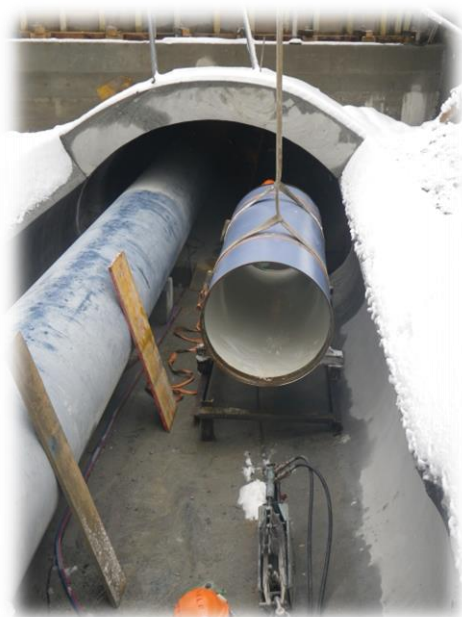
Nouvelle conduite passage sous Dranse
