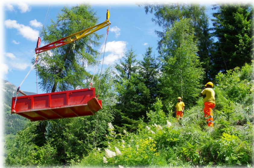
Transport de charge avec le blondin de chantier
