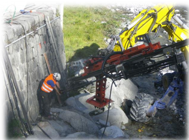
Forages pour l'installation du Blondin
