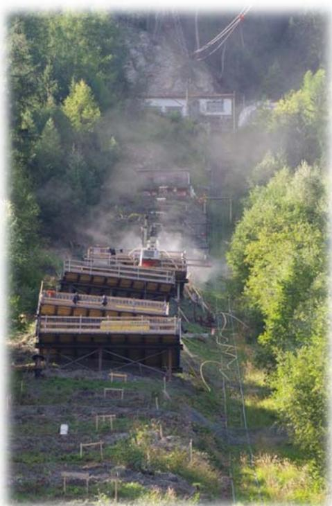
La construction d'une nouvelle conduite forcée extérieure et le remplacement de deux groupes de production datant de 1931 par un nouveau groupe, bat son plein.
