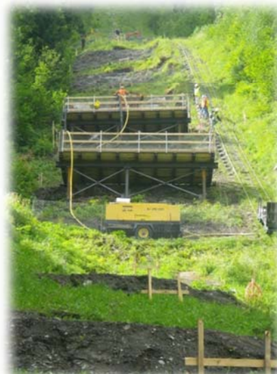
Plate-forme de forage
