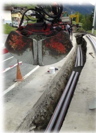
Mise en souterrain ligne MT Liddes
