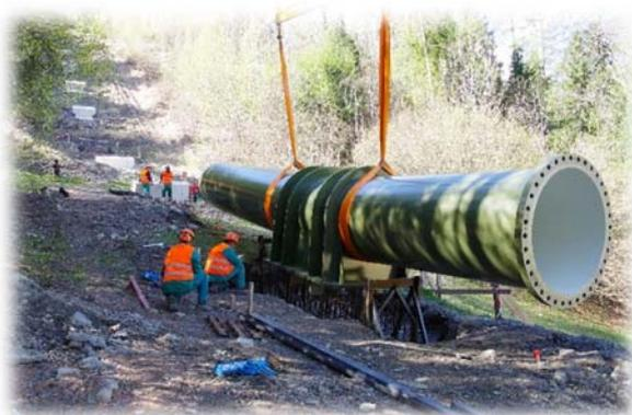
*Fixation d'un point fixe de la conduite forcée*
