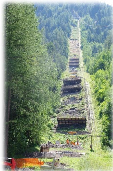
*Plateformes de forage et d'excavation des appuis de la conduite*
