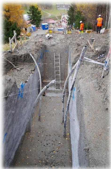
*Excavation et micropieux d'un point fixe*
