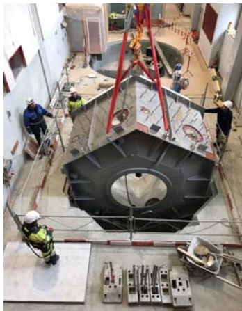
Mise en place du bâti de la turbine
